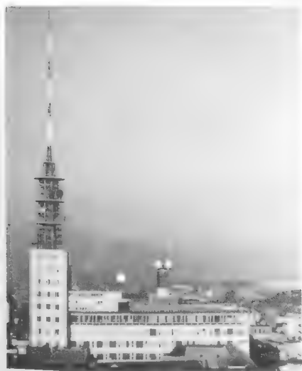
Fernmeldeamt Bremen mit 123 m hohem Mast mit Antennen für den neuen UHF-Fernsehsender in Kanal 29 und für den öffentlichen Landfunkdienst, rechts die mit Kunststoff-Wetterschutzhauben umhüllten Dipolgruppen des UHF-Fernsehsenders
